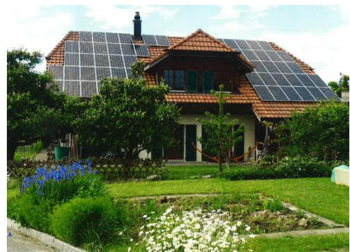
Sanierung Einfamilienhaus – Familie Frey
