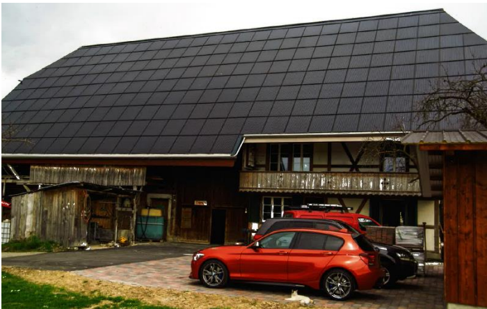
Wärmeverbund Kernenried - Urs Bütikofer
